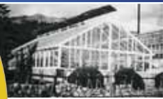
戦後に建設された二代目の温室
